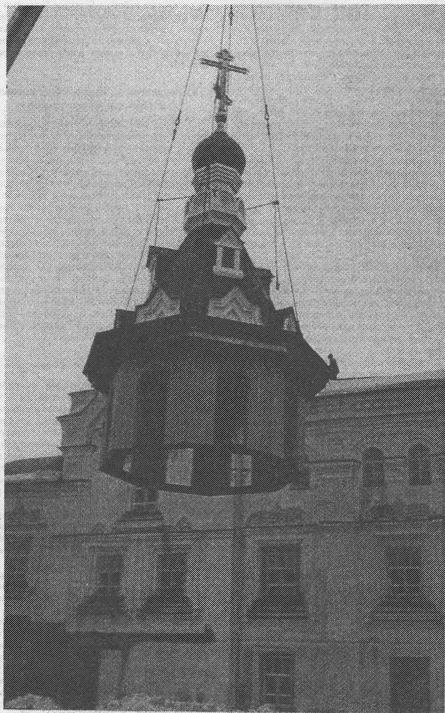
Рис. 59. Подъем готового завершения храма в Свижске, 2001 г.
