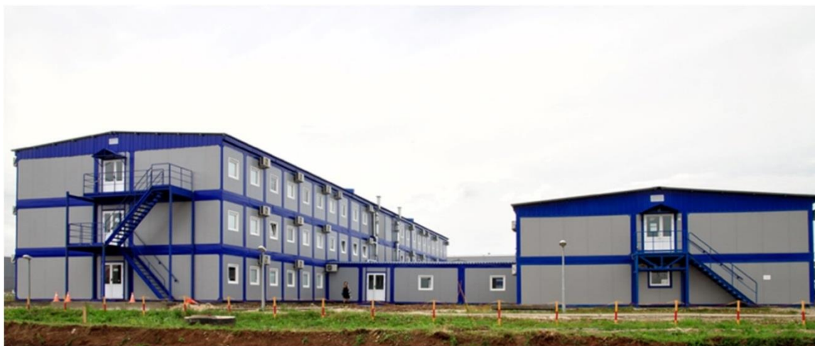
Рисунок 5.16 – Комплекс модульных зданий жилого и административно-бытового назначения
