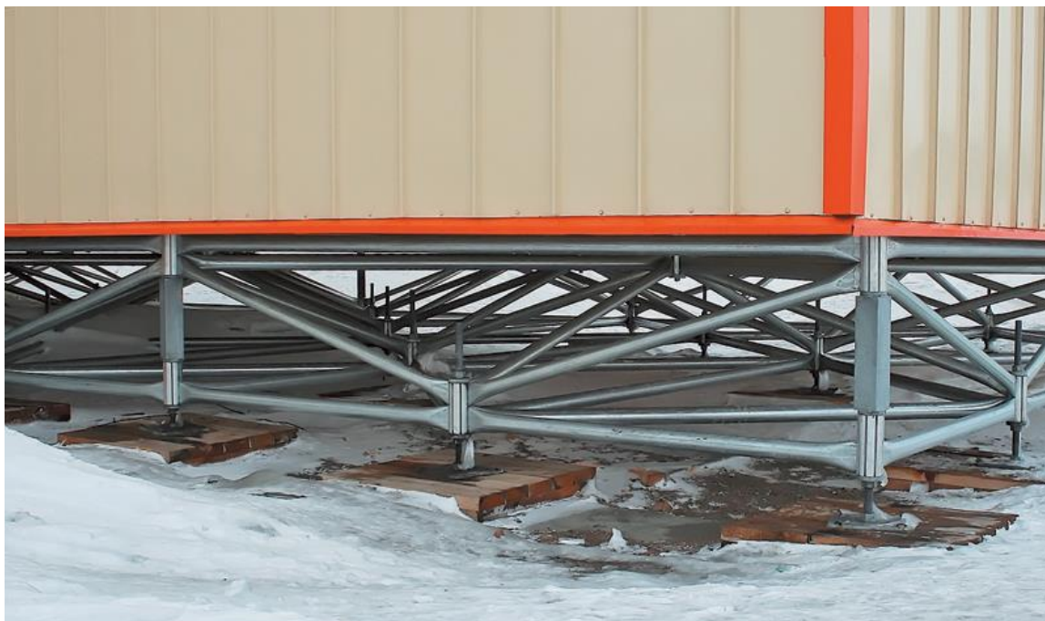
Рисунок 5.2.3 – Установка блок-контейнеров на вечной мерзлоте
