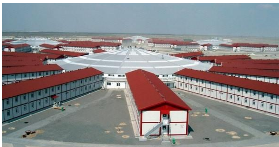
Рисунок 5.17 – Комплекс модульных зданий административно-бытового назначения
