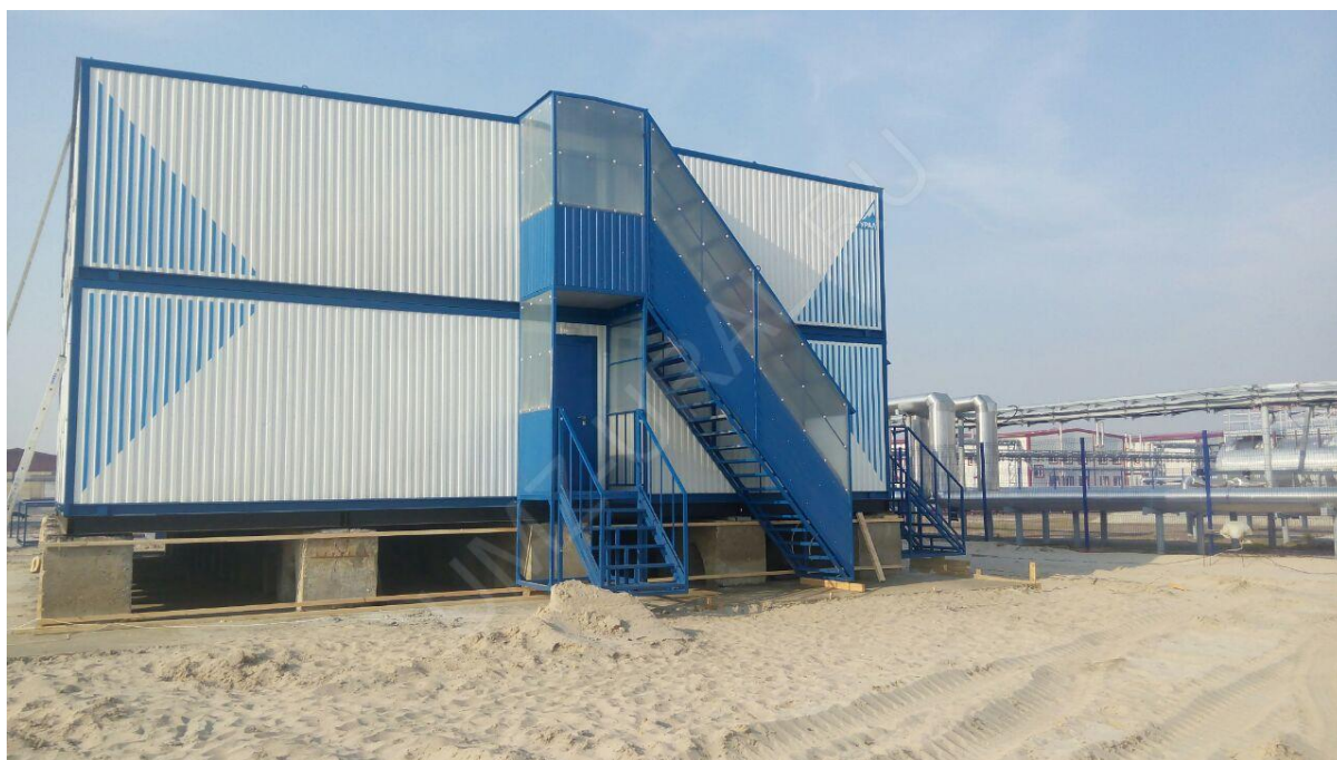
Рисунок 5.4 – Бытовое 2-этажное здание
