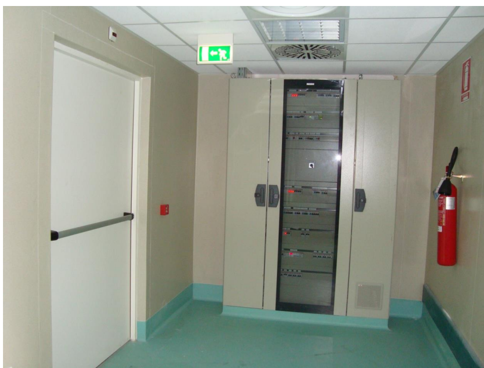
Рисунок 106 – Примеры дверей эвакуационных выходов с устройством «антипаника»
